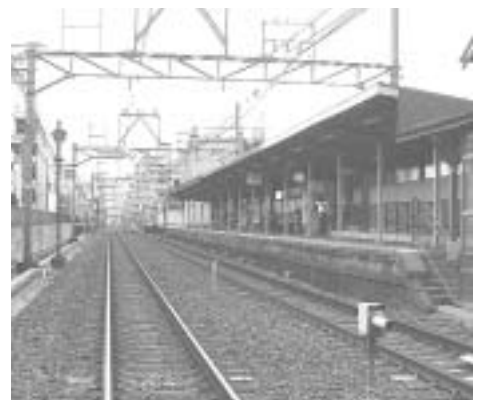
高架工事が行われる諏訪森駅
